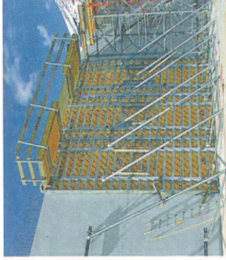
Bild G.1. Schalungselement Figure G.1. Formwork element
